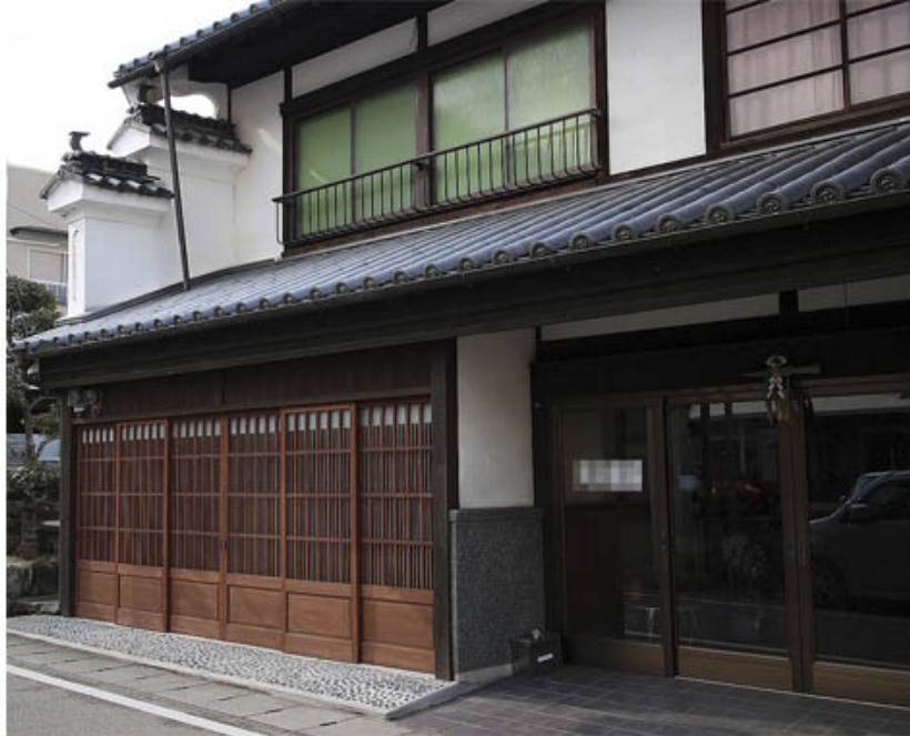
1階の屋根の左端にある防火壁が「うだつ」
