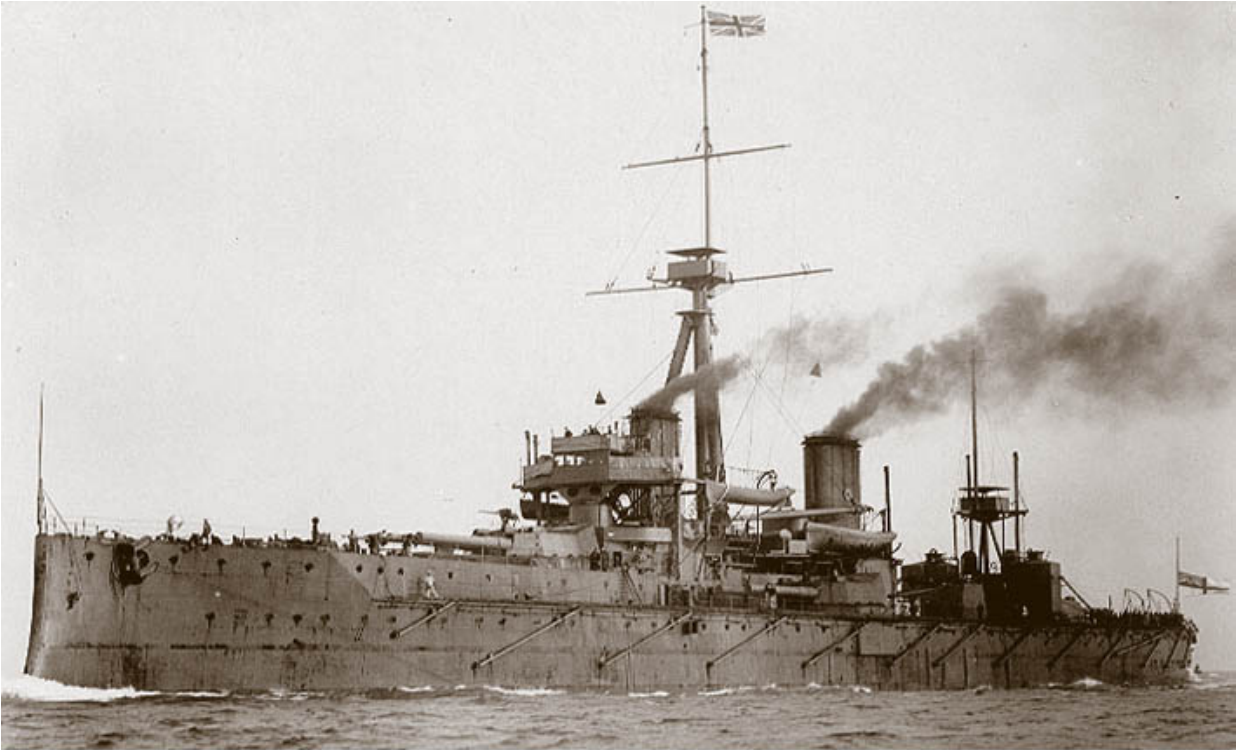
イギリス海軍の戦艦ドレッドノート。単一巨砲による武装と蒸気タービン推進が他の戦艦を圧倒した
